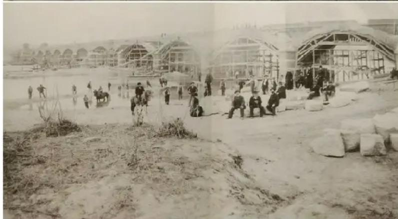
ferrovia". Fu solo allora che venne soppresso il ponte di barche. I lavori terminano completamente nel 1890 e la costruzione, che non manca di un suo fascino per i tempi, assume la conformazione che ha ancora oggi: 21 arcate e 507 metri di lunghezza, uno dei ponti più estesi e rilevanti del Paese.
